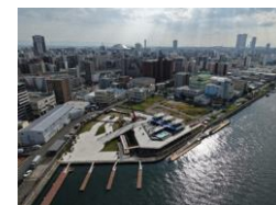
中之島GATEサウスピア
