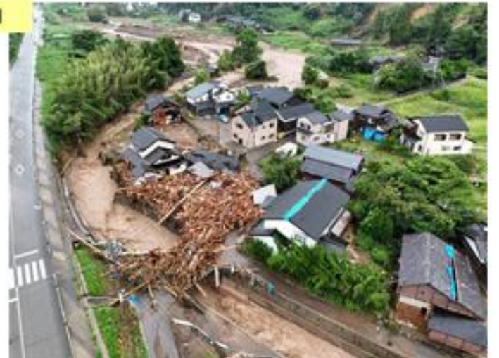
横断工作物（橋）に大量の流木が捕捉
