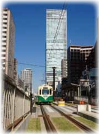
阪堺電気軌道上町線の軌道敷の芝生
