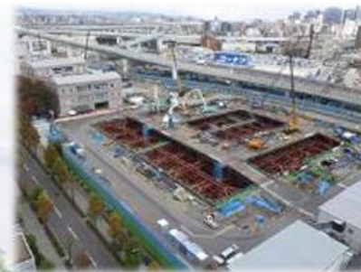
水処理施設Co打設
