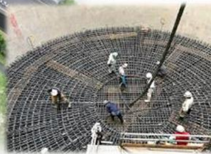
シールド発進立坑Co打設
