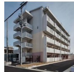
従前居住者向け市営住宅の建設
