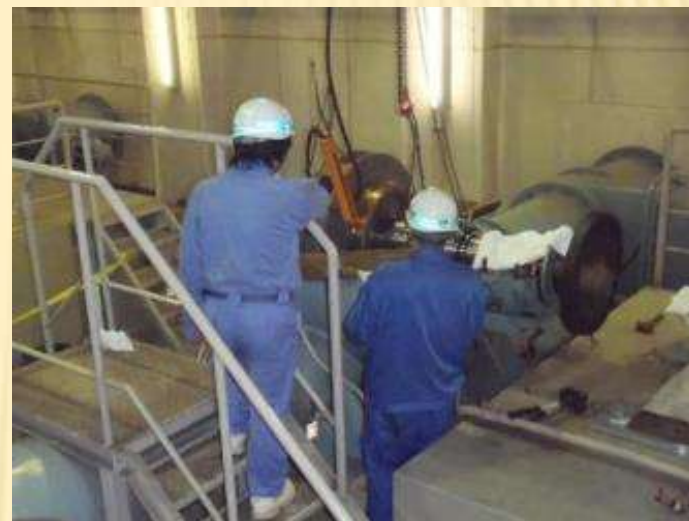
現場確認（機器分解整備立会）
