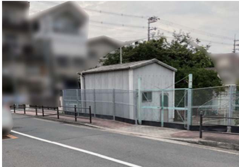
(撮影場所：平野区加美北 8－1－49 付近、撮影日時：令和 4 年 8 月 24 日 16 時頃) (上記 4 の登録農地南側から撮影したもの)
