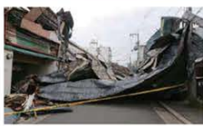
平成30年台風による被害(東成区)
