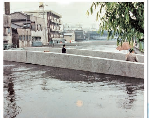
昭和57年7月大雨による水害(東成区)
