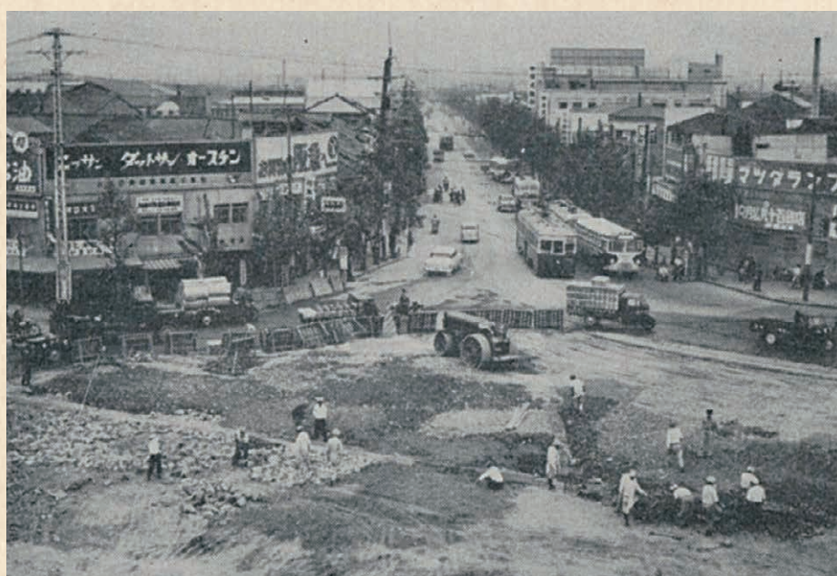
昭和30年頃、解体工事が進むロータリー
