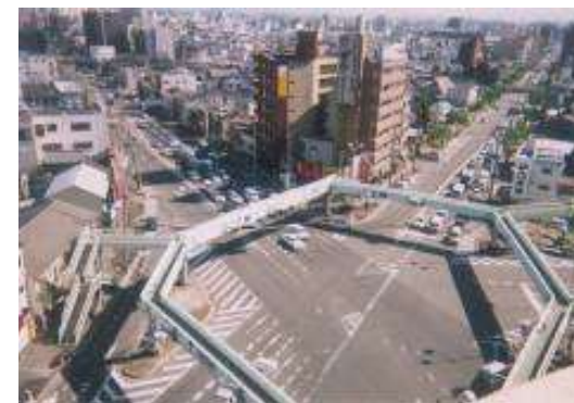
杭全交差点平成 15 年(2003 年)
