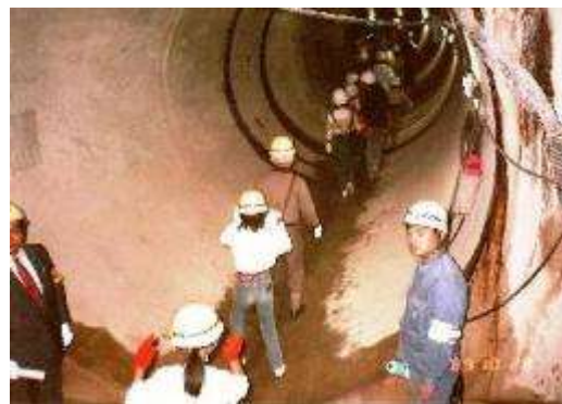
平成元年(1989年)なにわ大放水路見学会 1
