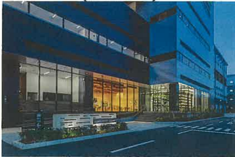
エントランスへのスロープの設置 (物流施設)
