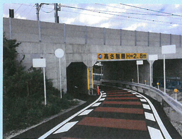
迂回仮道路（トンネル）
