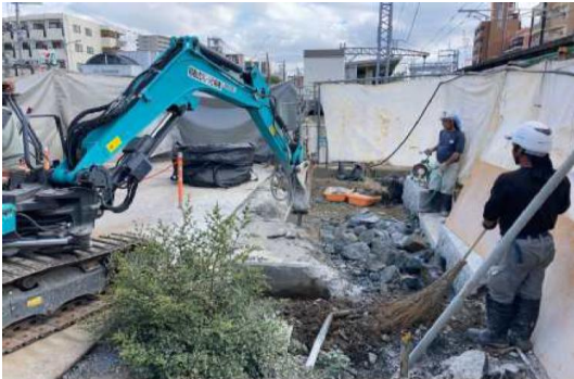
【7工区】下新庄踏切付近
