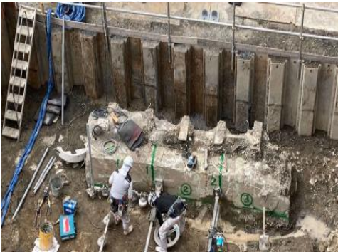
【6工区】浄水場付近
