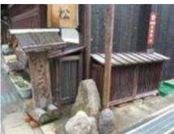
室外機を木製格子で隠す (滋賀県近江八幡市)
