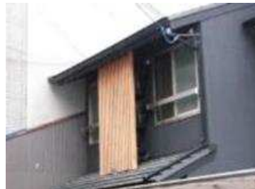
室外機を外壁色に着色し、木製格子で隠す (京都市下京区修徳地区)
