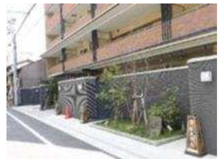
建物本体と異なる色の塀や植栽を道路に近い部分に設ける(京都市下京区修徳地区)
