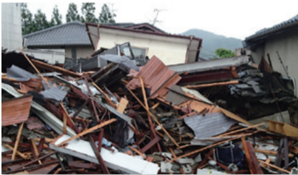
倒壊住宅の様子
