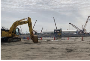
建築工事の様子
