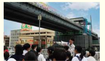
説明を受ける児童。工事用の橋から吊り下げた籠の中で解体作業が行われている
