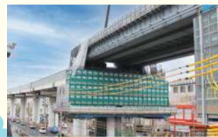
既存の高速道路橋の上に工事用の橋を架ける
