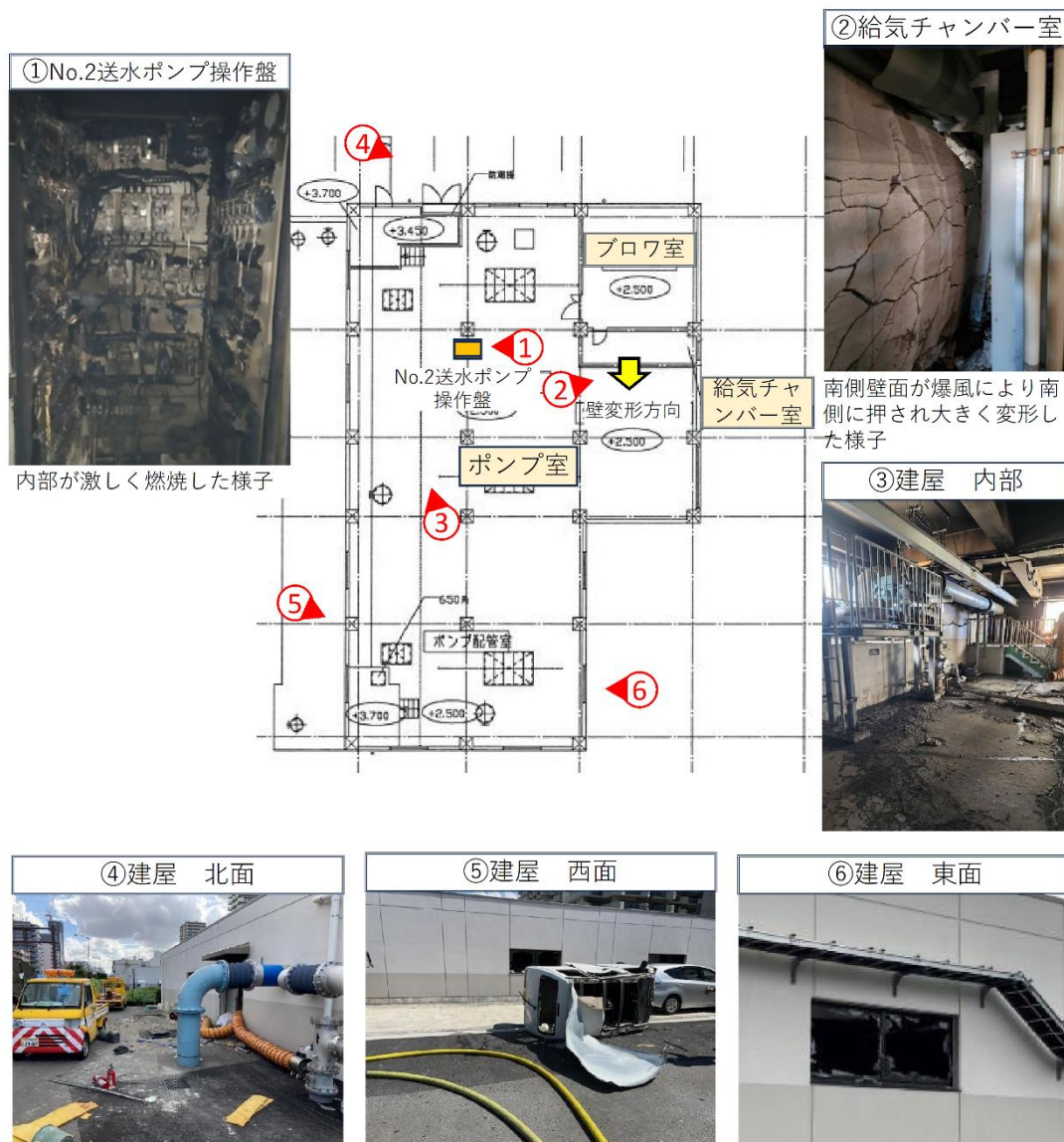
図 2-3 事故現場の状況（本滞水池西棟建屋）
