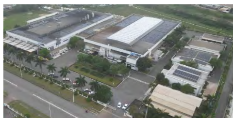
アルミホイール製造工場への屋根置き 太陽光発電システムの導入
