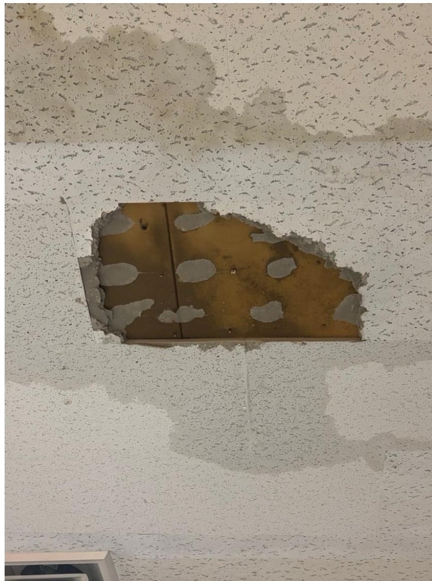
天井ボード落下場所及び落下箇所
