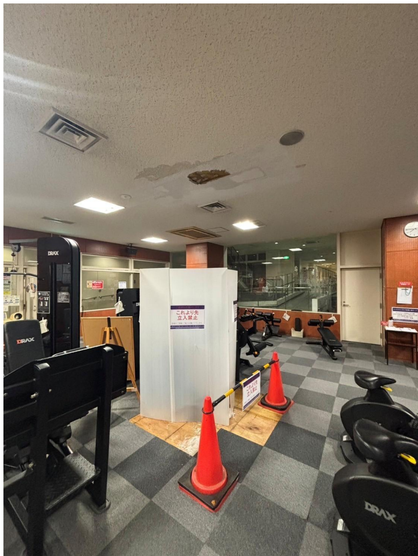
天井ボード落下場所及び落下箇所
