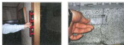
水平器による柱の傾きの計測
