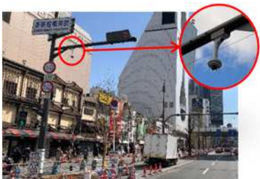
荷捌きスペース監視カメラ
