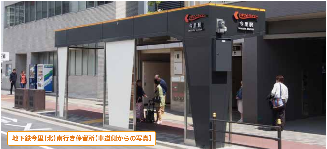
地下鉄今里（北）南行き停留所【歩道側からの写真】
