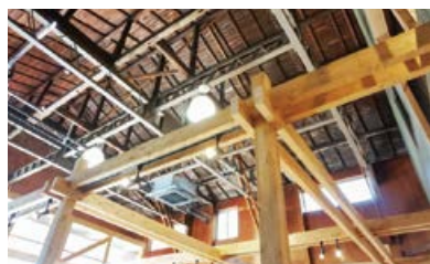
▲見上げた高い天井は圧巻だ。
