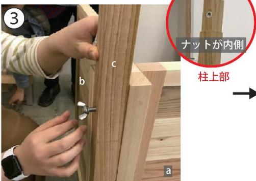
[a] と [b] の交差した外側に [太] ボルトで柱 [c] を取り付ける。柱上部のナットが内側になるよう、向きに注意。
