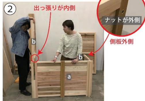
前板 [a] の両側の溝に側板 [b] を差し込む。下部の出っ張りを内側に、脚に付いているナットを外側にすること。
