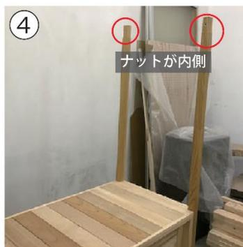
柱 4本、[太]ボルト計 8本を取り付け、ナットが内側に来ていることを確認する。
