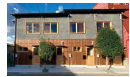
改修イメージ(改修前→改修後)
