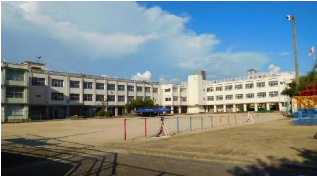
写真：生野南小学校
