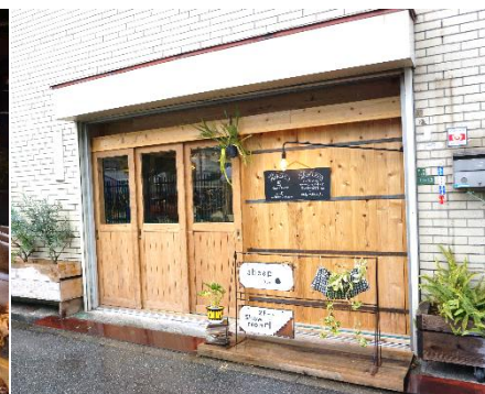
▲ 入口はシャッターを取り外して 温かみのある木製の引き戸に 変更。
