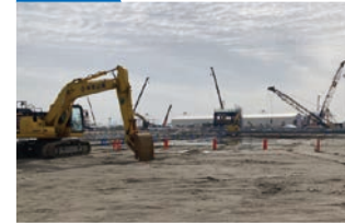
建築工事の様子
