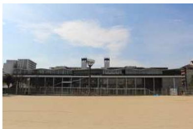
城東区複合施設 北側外観
