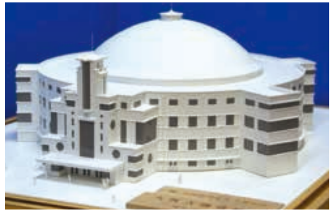
大阪大国技館の概要：敷地6,000坪・建坪3,000坪・鉄筋コンクリート4階建ドーム式・収容人員25,000人・昭和12年5月竣工
