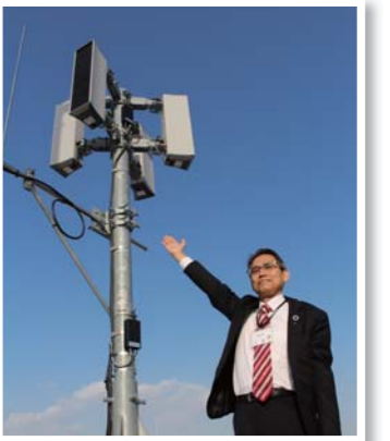
区役所屋上に設置している防災スピーカー
