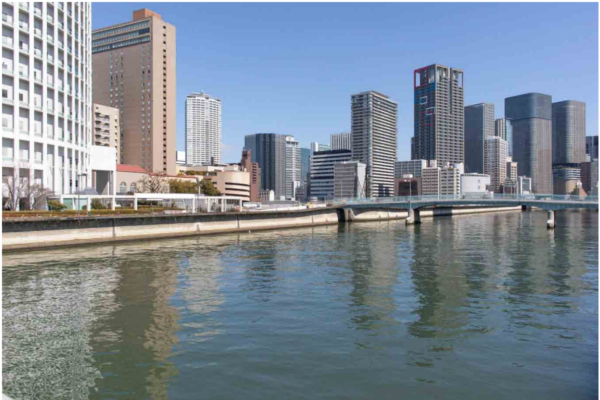
土佐堀橋からの景観（現況）
