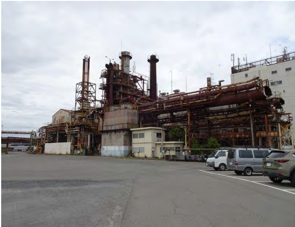
③西部（解体予定 発電所）
