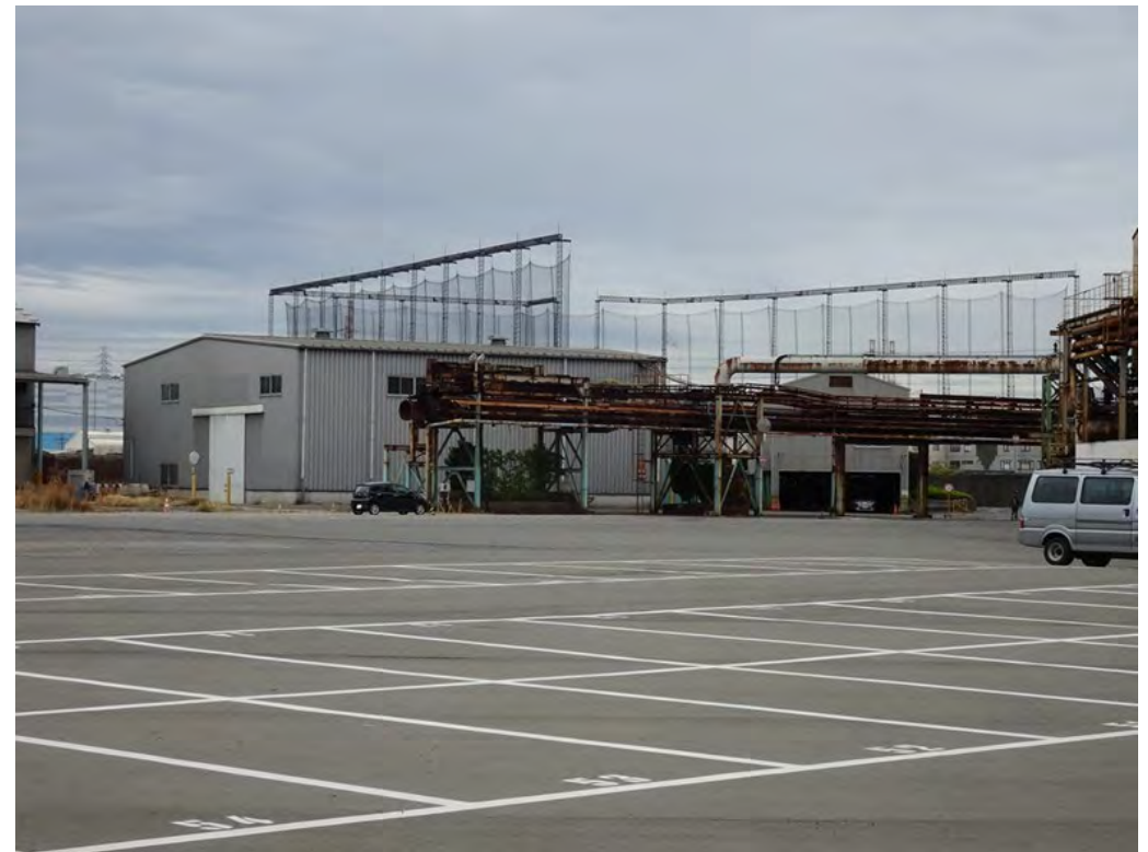
④南部（解体予定 倉庫）
