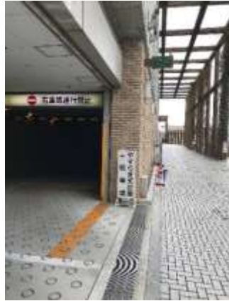
No.15 駐車場入口看板
