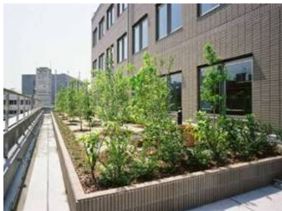
福島区役所新庁舎の屋上緑化
