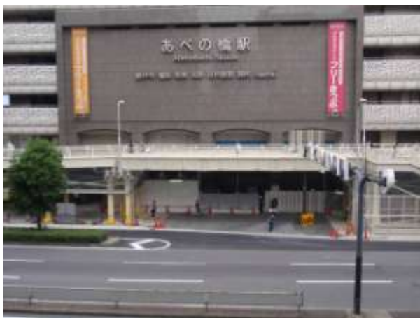
図 4.7.9 工事中の北側出入口の状況
