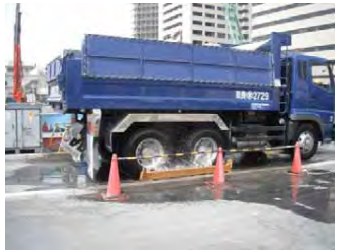
写真4：タイヤ洗浄状況
