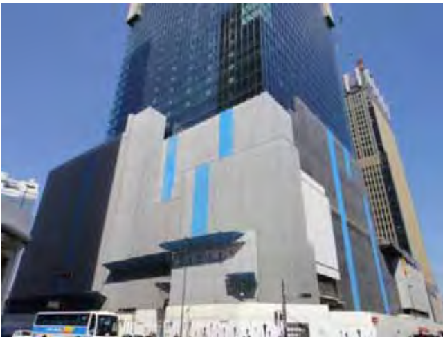
写真3：メッシュネット設置状況
