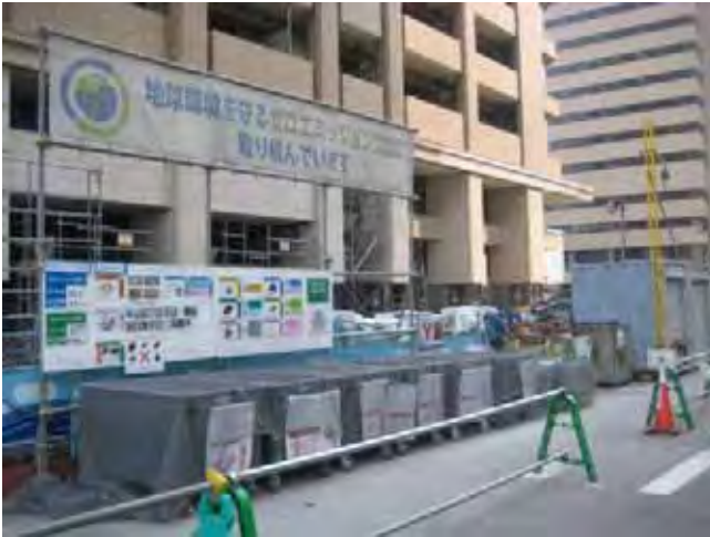
写真7：廃棄物専用ヤード設置状況
