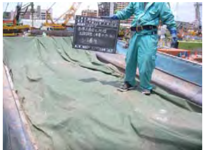
写真6：不適合土シート掛け状況
