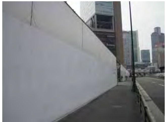
写真2：仮囲い設置状況
