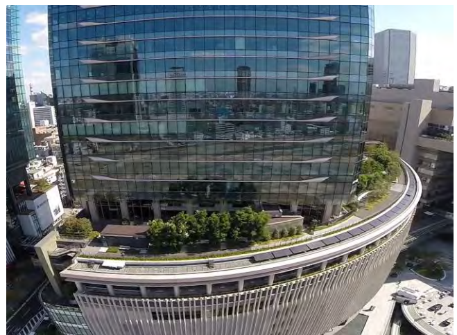
写真9 屋上緑化（A地区）
