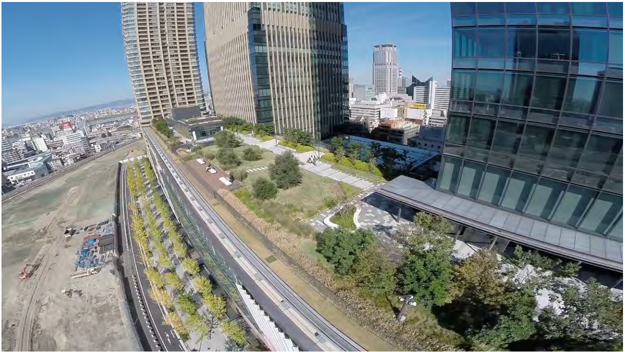
写真10 屋上緑化（B地区）
