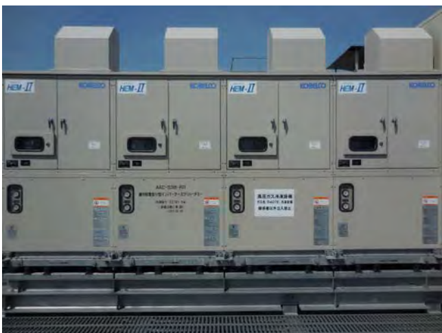
写真4 低騒音・低振動型空調設備
