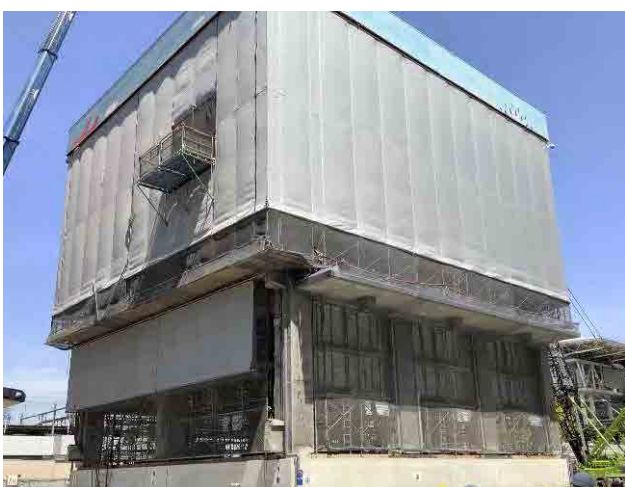
写真9 保存部分保護の状況
