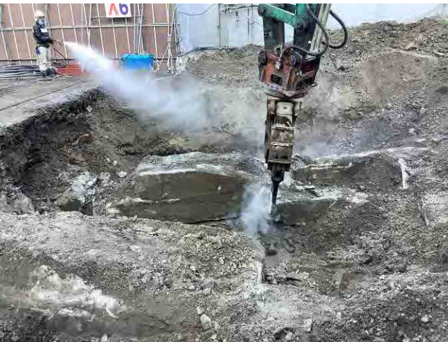
写真3 粉じん防止散水の様子
