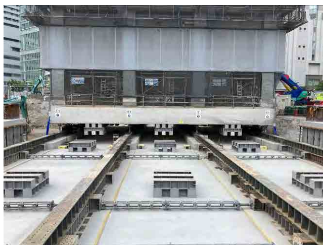
写真8 保存部分曳家工事の状況
