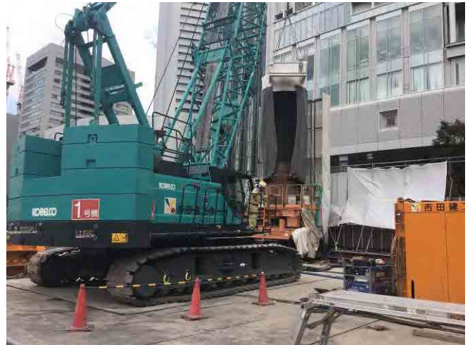
写真2 掘削バケット養生の状況
