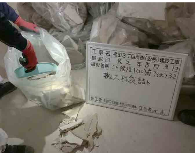
写真5 石綿除去工事の状況
