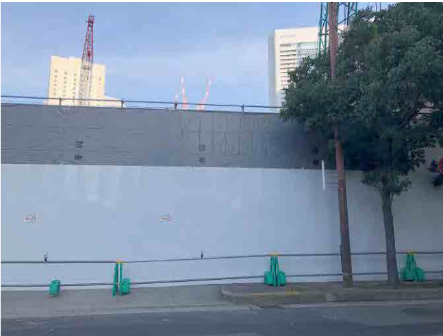
写真1 仮囲い、防音パネルの設置状況
