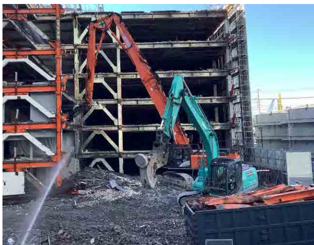
写真7 解体ガラスの小割と分別の状況
