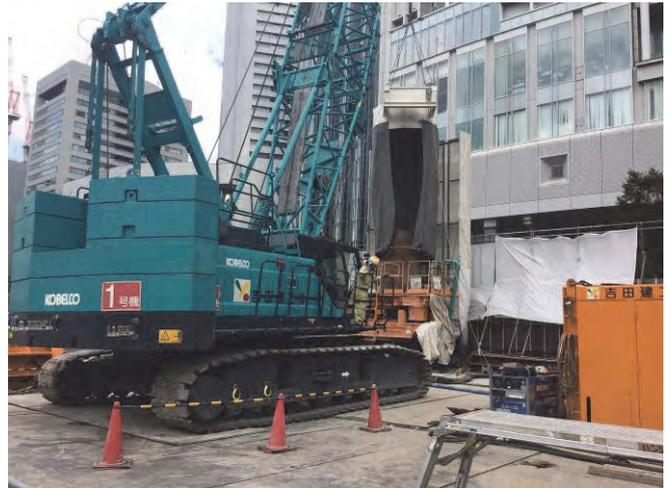
写真2 掘削バケット養生の状況
