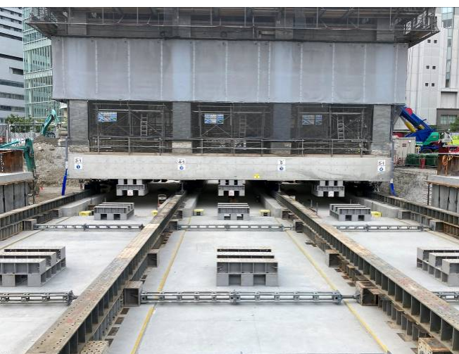
写真11 保存部分曳家工事の状況
