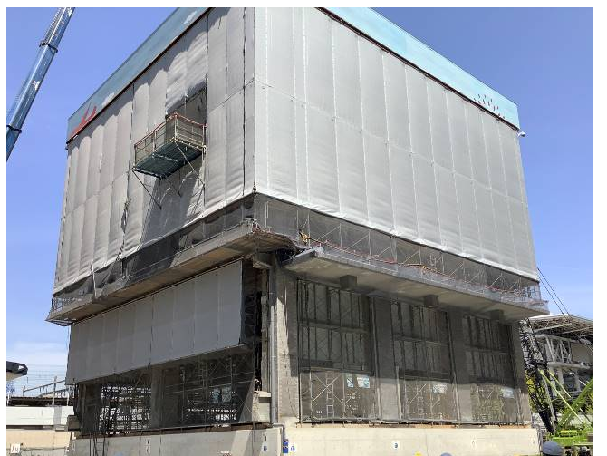
写真12 保存部分保護の状況
