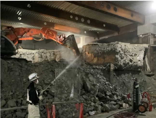
写真3 粉じん防止散水の様子
