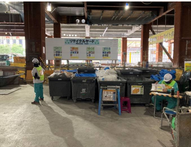
写真9 廃棄物リサイクルヤードの状況
