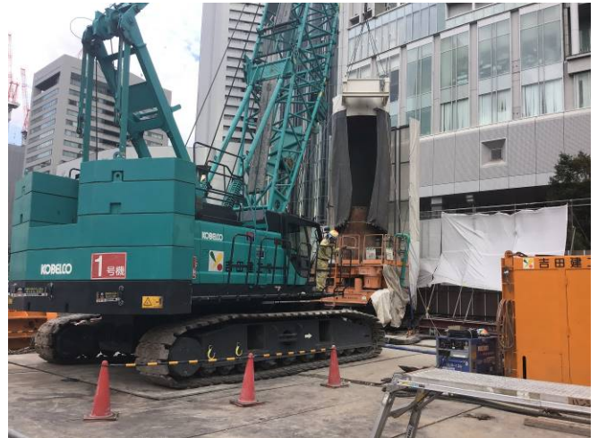
写真2 掘削バケット養生の状況
