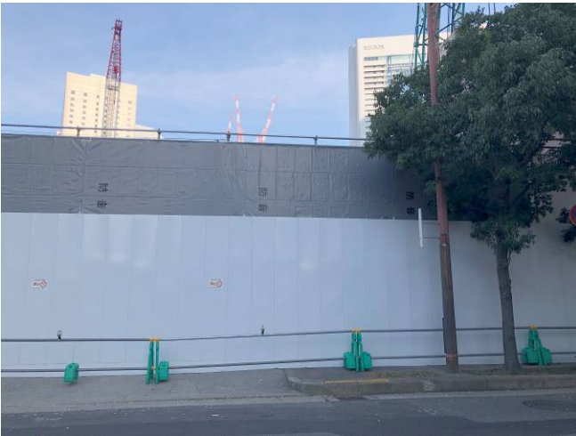
写真1 仮囲いの設置状況
