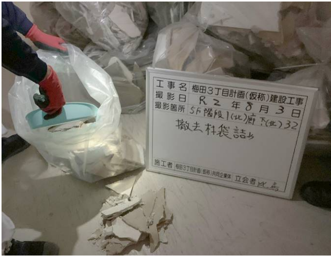
写真7 石綿除去工事の状況
