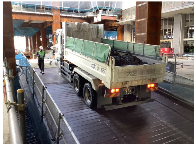
写真4 タイヤ洗浄の様子
