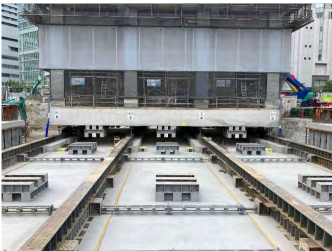
写真11 保存部分曳家工事の状況
