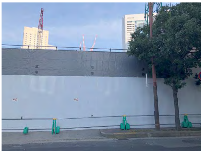
写真1 仮囲いの設置状況
