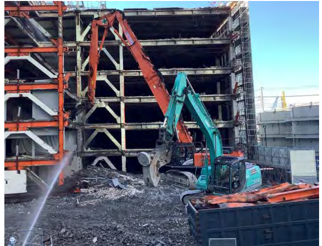
写真10 解体ガラの小割と分別の状況
