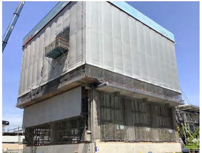
写真12 保存部分保護の状況
