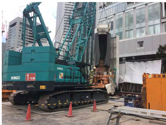
写真2 掘削バケット養生の状況
