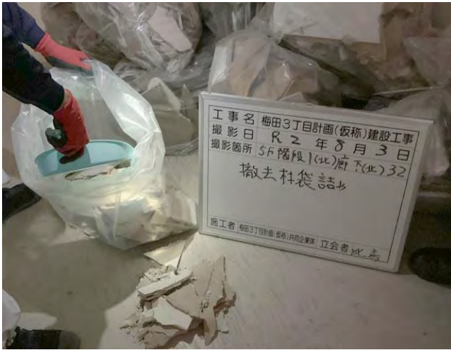
写真7 石綿除去工事の状況
