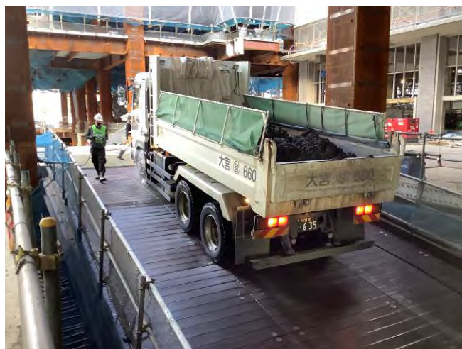
写真4 タイヤ洗浄の様子
