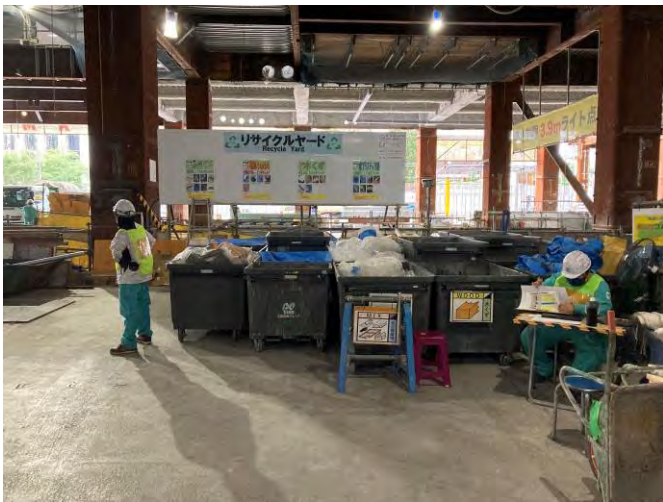
写真9 廃棄物リサイクルヤードの状況
