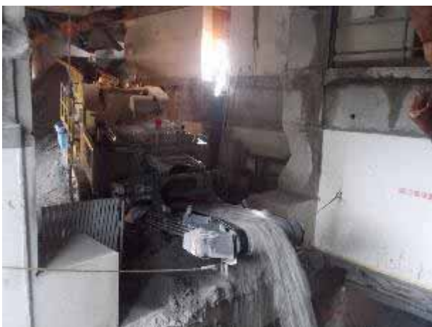
写真11 自走式破砕機による小割碎石再生状況
