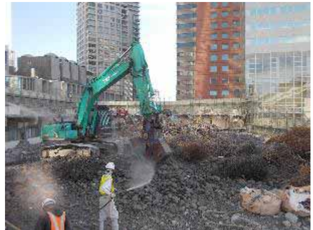
写真10 解体ガラの小割と分別の状況
