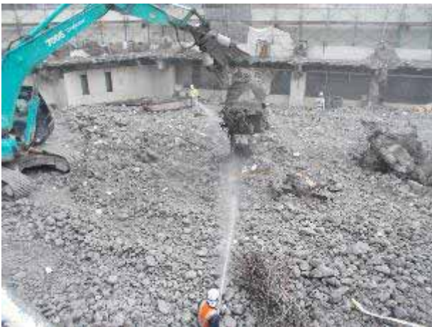
写真3 粉じん防止散水の様子
