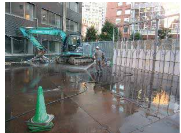
写真6 敷鉄板・散水洗浄の状況
