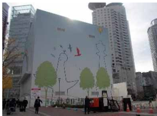
写真12 中央郵便局の保存部分の状況
