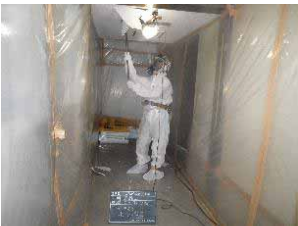
写真5 石綿除去工事の状況
