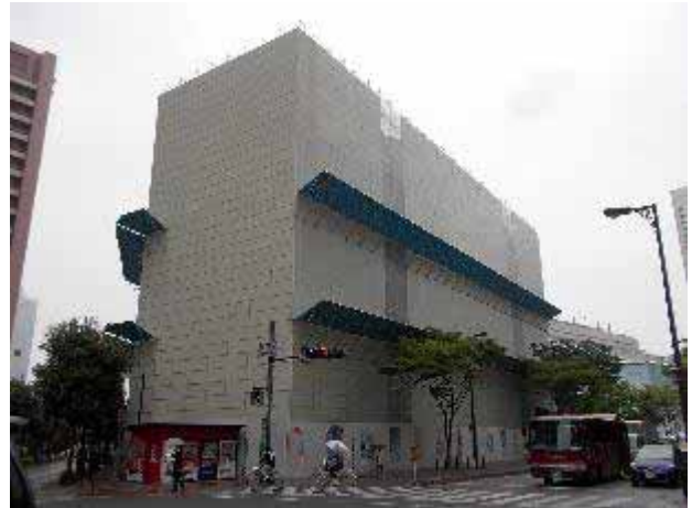
写真2 防音パネルの状況
