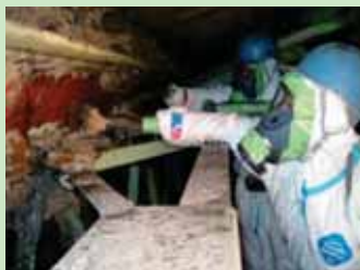
吹付け石綿の除去作業の様子
