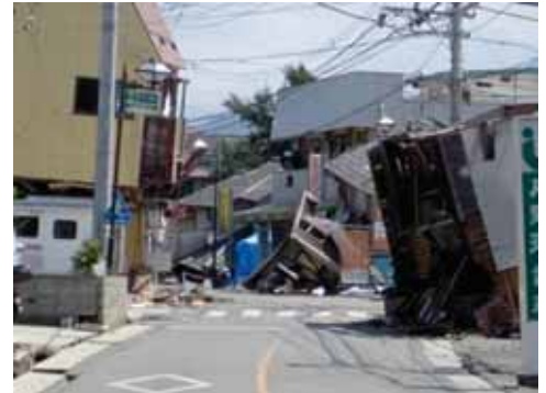
地震で損壊した建物
