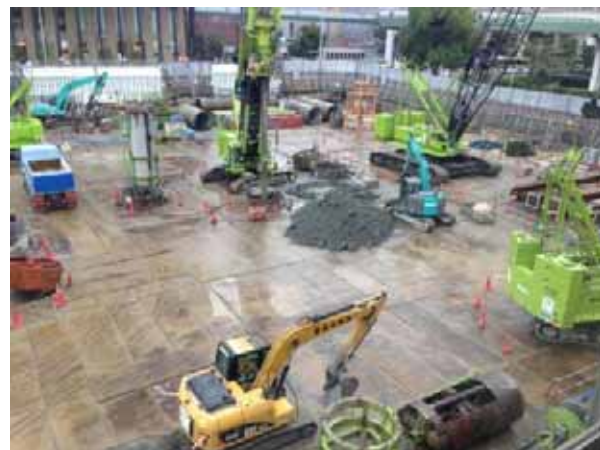
写真6 車両通行路全面鉄板敷き (タイヤへの泥土等の付着回避、粉じんの飛散防止等)
