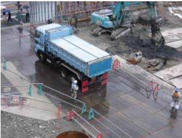
写真7 上蓋付き汚泥搬出車両とタイヤ洗浄 (車両による粉じんの飛散防止)
