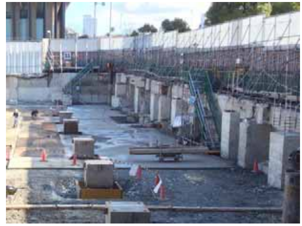
写真8 既存地下外壁の残置と山留壁として利用 (地盤沈下防止)
