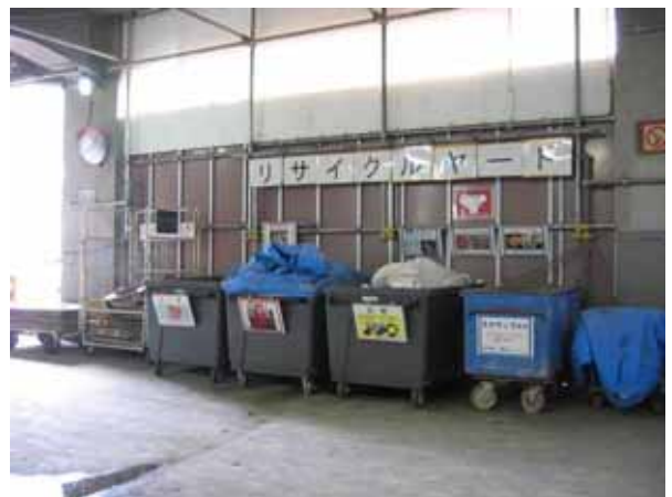
写真10 場内廃棄物専用ヤード (廃棄物の分別)
