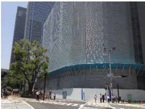
写真1 仮囲い (鋼板 3.0m + 養生用足場を兼ねた防音パネル)
