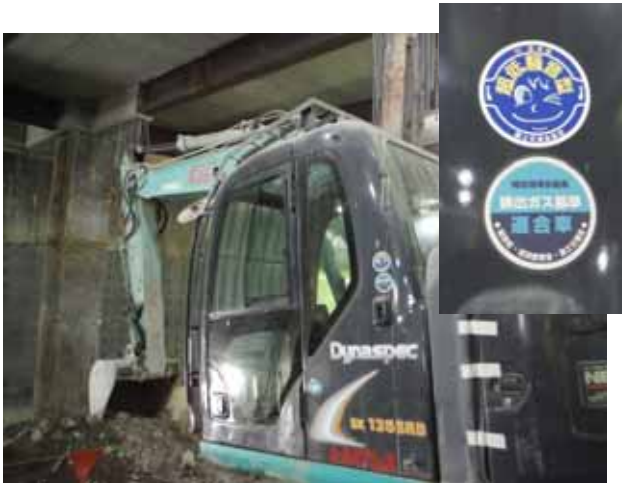
写真3 環境配慮型建設機械の使用 (排ガス基準適合、超低騒音型機械)
