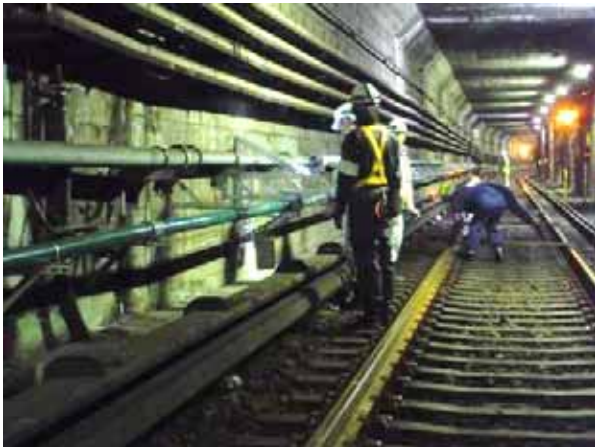
写真9 近接地下軌道の計測管理 (地盤沈下防止)
