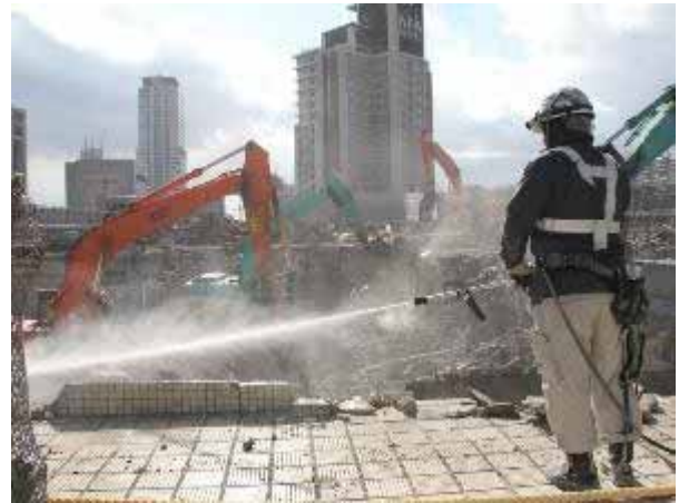
写真2 解体時の散水 (粉じんの発生・飛散防止)
