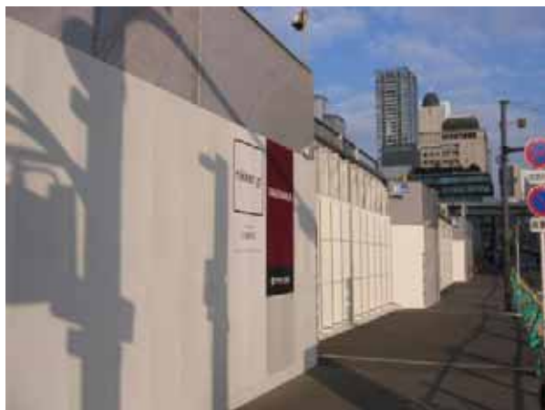
写真5 仮囲い(鋼板 + 上部養生シート) および四ツ橋筋側に工事ゲート設置
